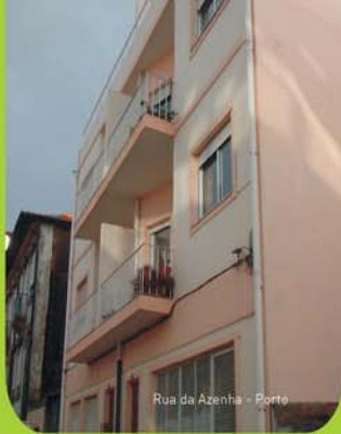
Reabilitação integral exterior e interior do edifício: cobertura, terraços, fachadas, rede de saneamento, rede de abastecimento de água, rede eléctrica e reabilitação interior em oito frações (paredes, pavimentos e tectos). Através do programa REDRIA (I.N.H./C.M. Porto).
