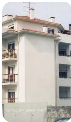
Reabilitação do edifício: isolamento térmico pelo exterior, do tipo ETICS, com acabamento em granulado de pedra natural.
