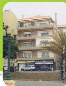
Reabilitação integral do edifício: cobertura, terraços e fachadas (remoção total e nova aplicação de elementos cerâmicos sobre reboco de gesso armado).
